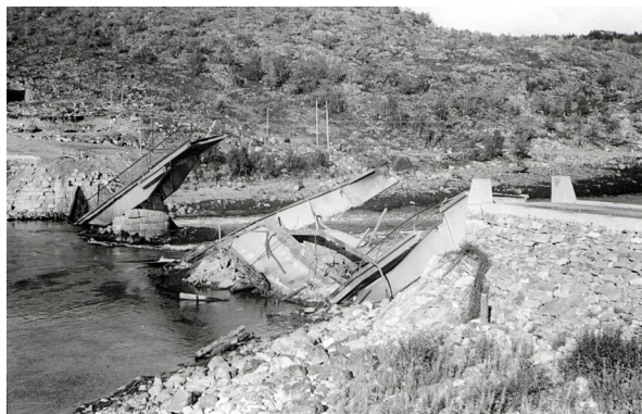
Strømmen bru ble sprengt av tyske styrker da de trakk seg tilbake fra Petsamo under "operasjon nordlys" i 1944. Foto: Ukjent fotograf/Norsk vegmuseum, Statens vegvesen
